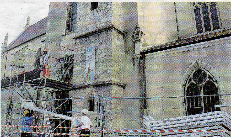
C'est parti pour un mois de montage de l'échafaudage.
