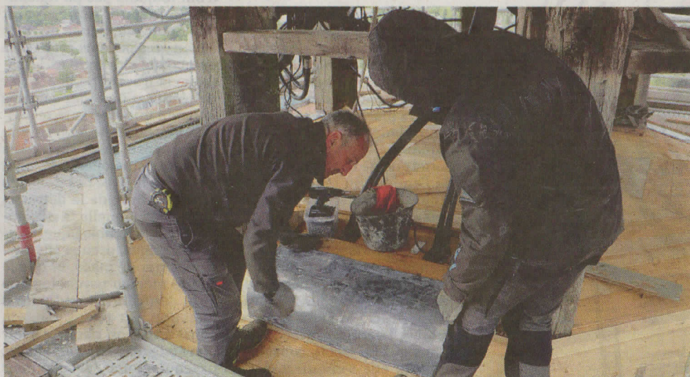
Les travaux se concentrent actuellement sur l'étanchéification au plomb.
